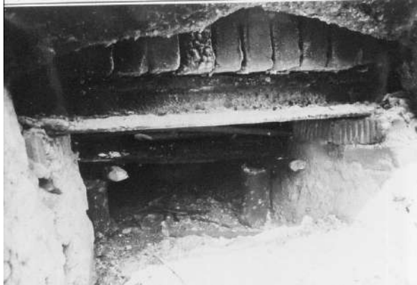
Figure 4. Détail du treillis situé juste au dessus de l'orifice d'allumage, qui supporte le chargement du four et permet aussi l'allumage
